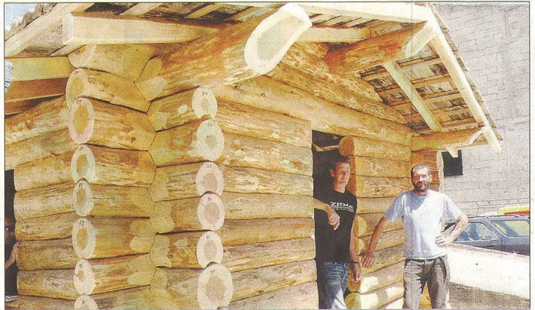
► Rajko et Romain, bucherons à Forcalquier, ont construit cette fuste en bois de cèdres du Luberon en douze jours. Le coût d'une telle construction : 6 000 euros. / PHOTO C.M.
